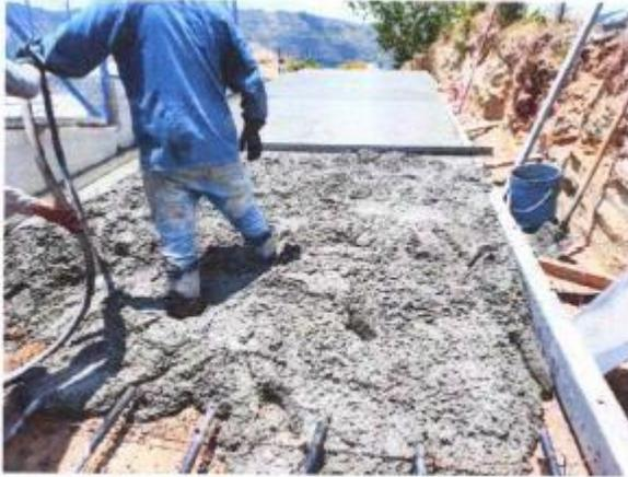
Elaboración via en pavimento rígido fundida placa en concreto espesor 25 cm
